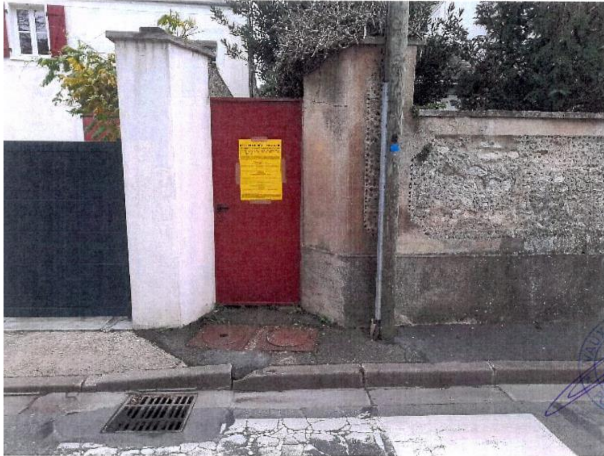
Photo N°1 - rue de la baste
